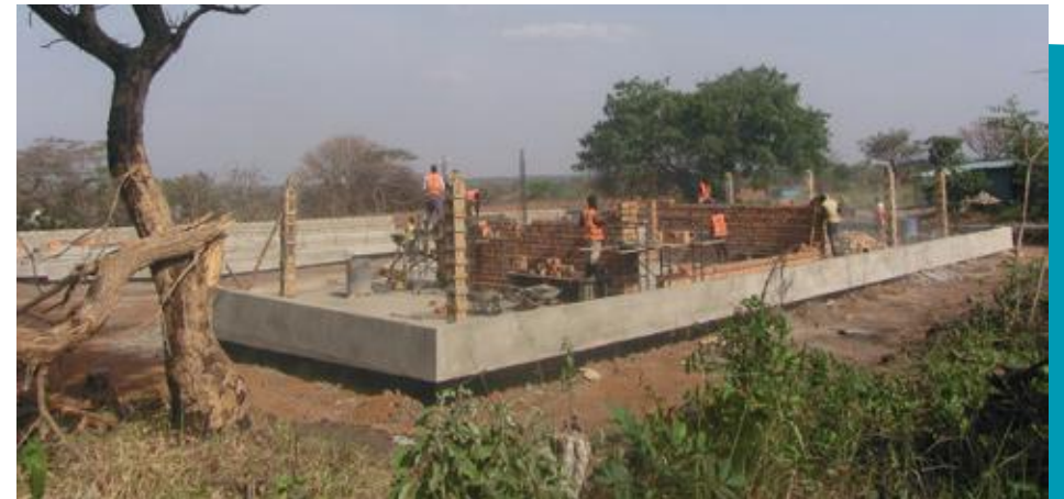
Bau des ersten Klassengebäudes
