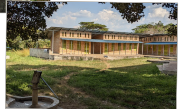
Schulgebäude mit den neuen Dächern und Brunnen
