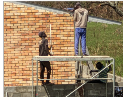
Arbeiter auf der Baustelle, hier beim Erstellen der Dachkonstruktion des letzten Klassenraumkomplexes.
