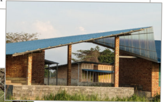
Schulgebäude mit den neuen Dächern
