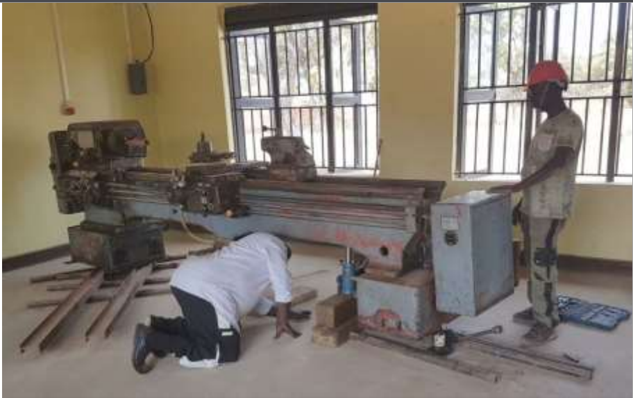
Positionieren der tonnenschweren Drehbank in der Metall-Lehrwerkstatt
